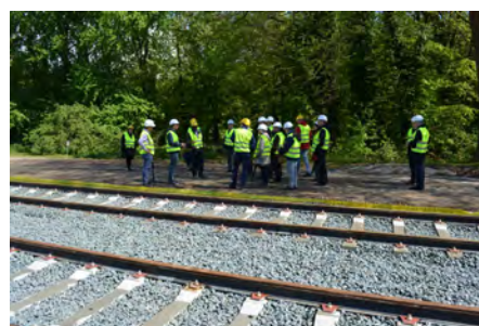
Voies de tram et promenade à côté du parc
