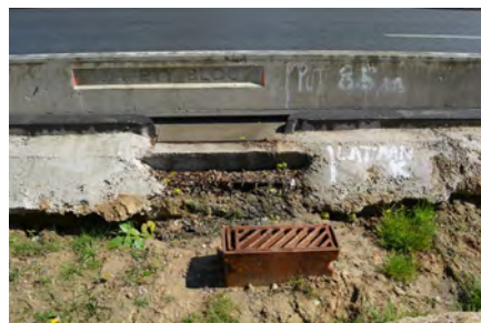
Travaux d'excavation pour une noue. La fente sous la bordure laisse passer l'eau de la chaussée, alors que l'avaloir servira de trop-plein
