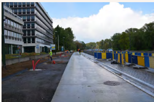
Réaménagement du côté des bâtiments.
